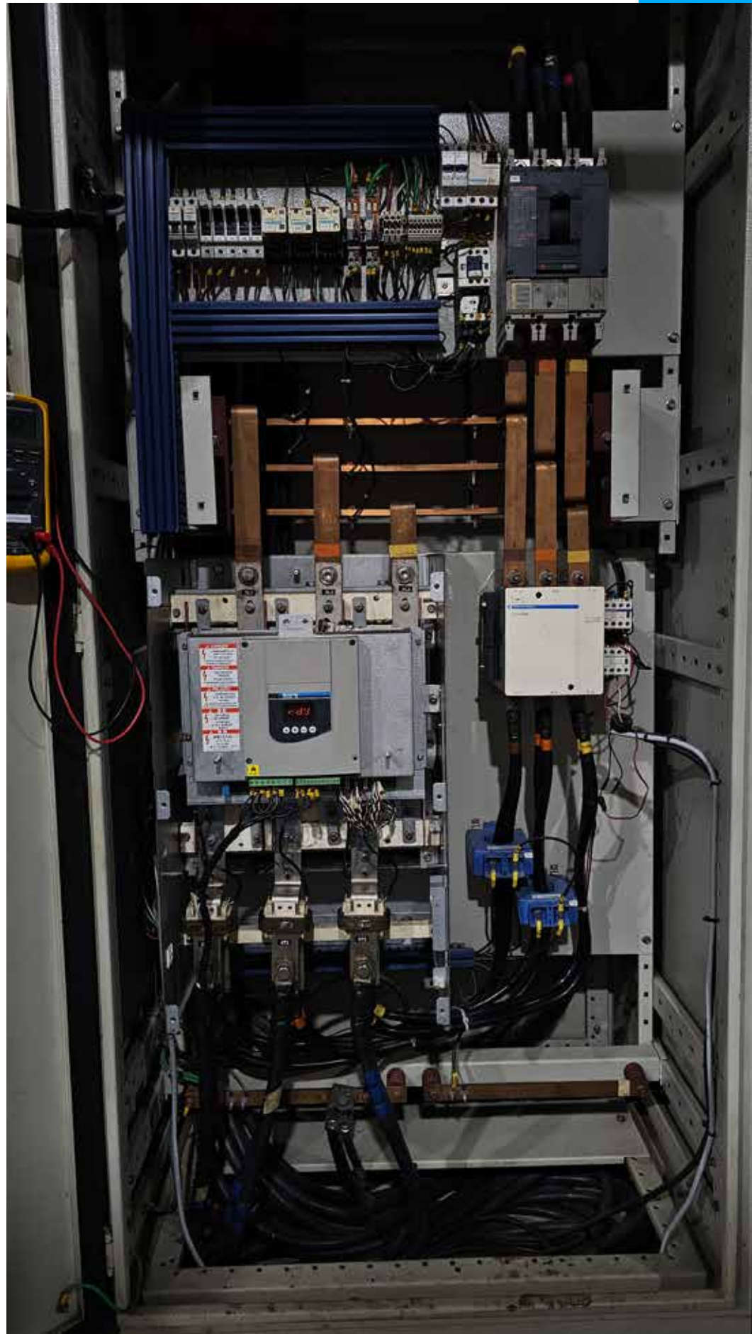
Reparación de arrandor suave tecnología Telemecanique
