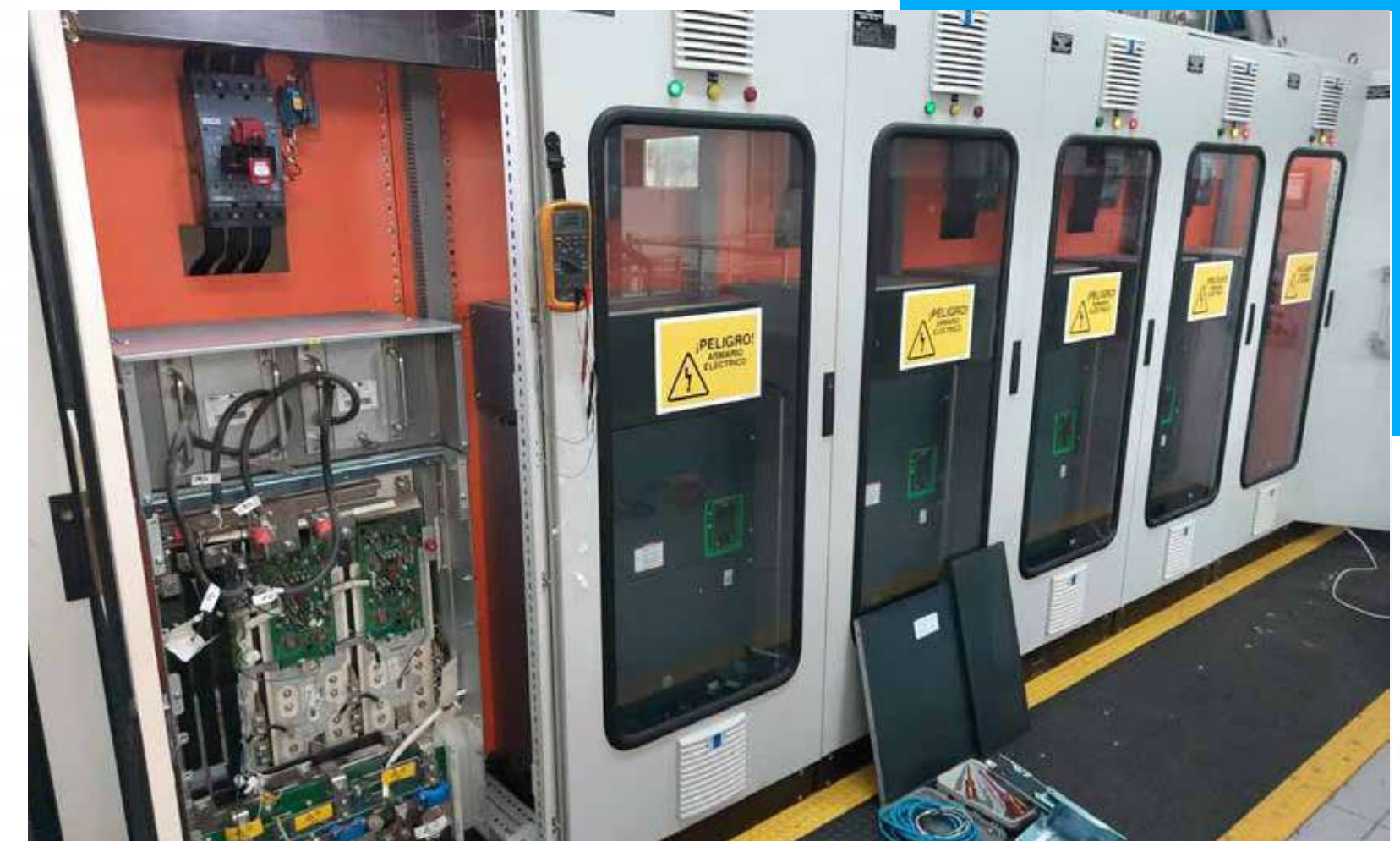
Mantenimiento de Variador de frecuencia tecnología Schneider
